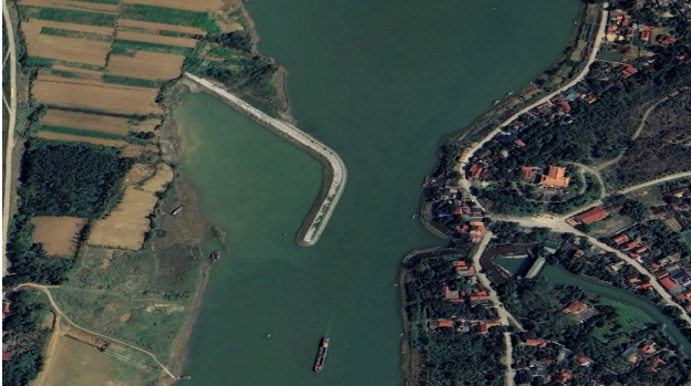
Hình 6. Kè mở hàn tại Trạm bơm Hoàng Khánh
