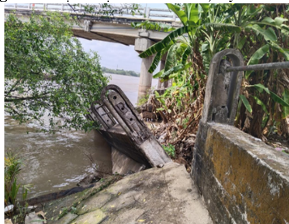
Hình 3. Hiện trạng sạt lở tuyến kè [3]
