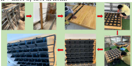
Hình 2. Quy trình lắp ráp khung vườn và thiết bị tưới
