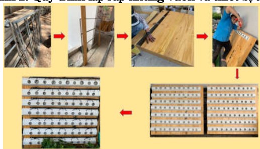
Hình 3. Quy trình lắp ráp khung vườn và thiết bị tưới
