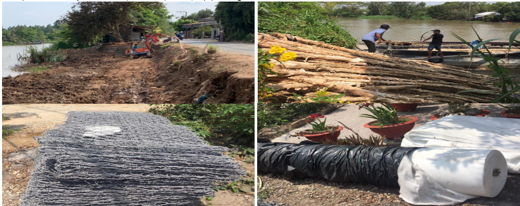
Hình 8. Phát quang mặt bằng và tập kết vật liệu
