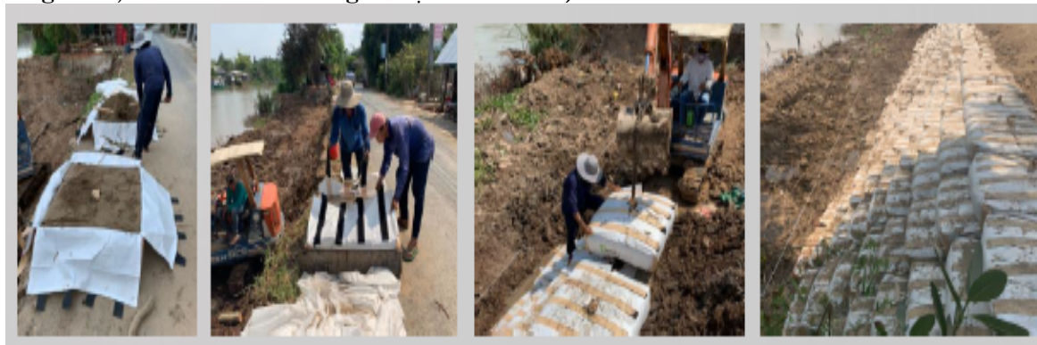
Hình 10. Thi công túi vải địa kỹ thuật
