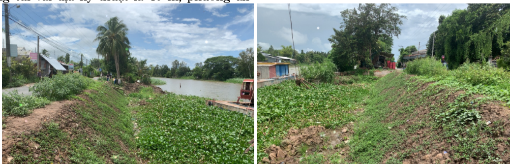
Hình 14. Thí điểm giải pháp sử dụng túi vải địa kỹ thuật sau 2 tháng hoàn thiện
