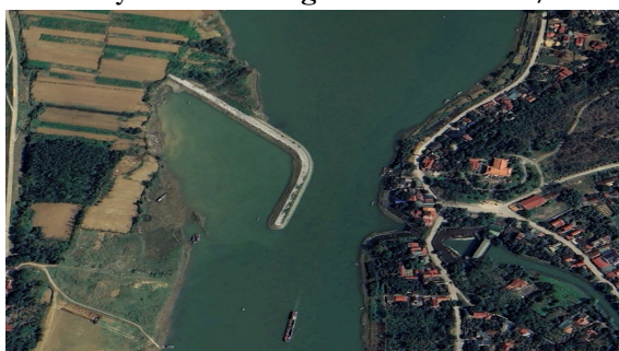
Hình 6. Kè mở hàn tại Trạm bơm Hoàng Khánh
